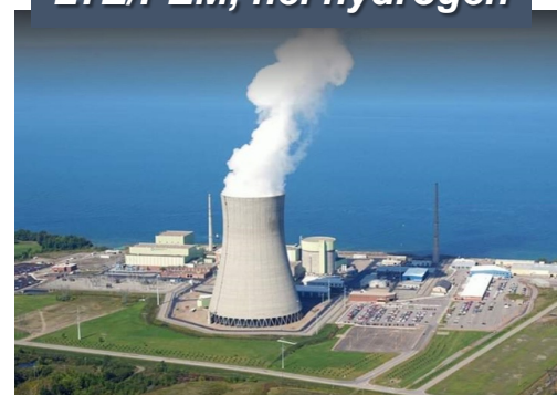
Nine Mile Point Nuclear Power Plant LTE/PEM, nel hydrogen
